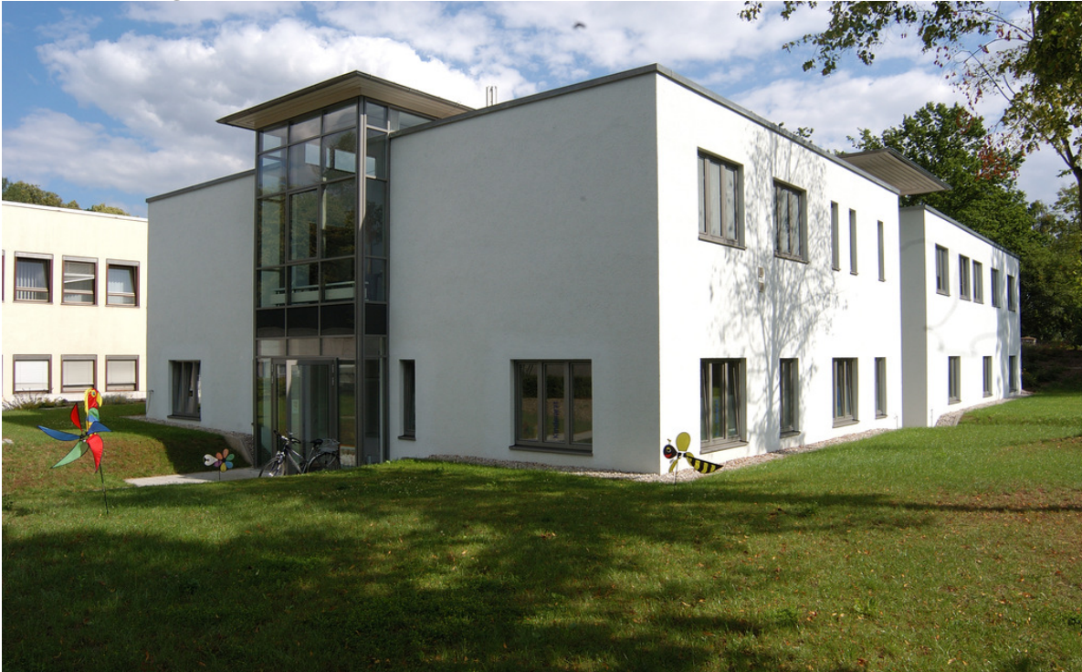
Abbildung: Krankenhaus Aichach
