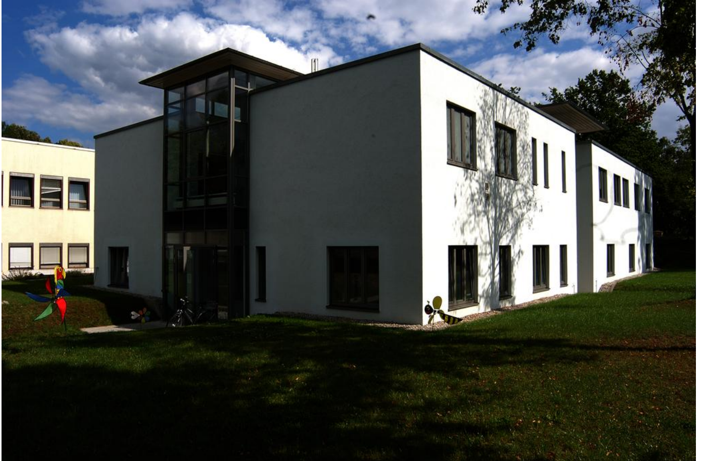
Abbildung: Krankenhaus Aichach
